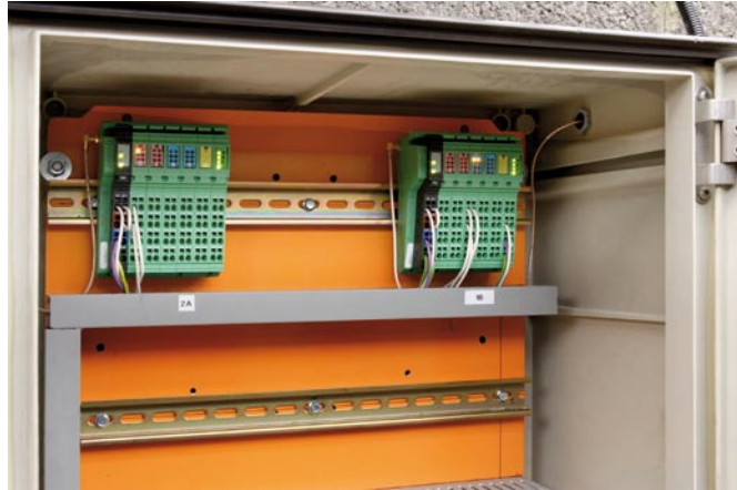
Pomphuis is draadloos verbonden met het gasverdeelstation en met de energieregistratie.
