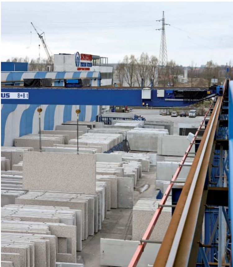
Het gps-systeem op de twee kranen kan de plaats van de platen bepalen
