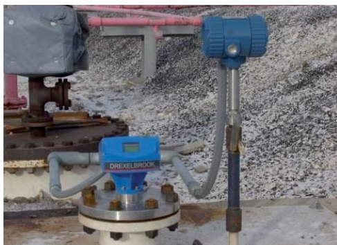
Een ultrageluidssensor op de pomp meet het niveau. Bij het bereiken van de bovenste alarmgrens wordt een extra digitaal alarmsignaal gegenereerd.
